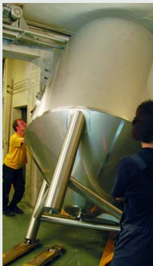
Montage der neuen Gär- und Lagertanks in der Braustube. Sie erweitern die Braukapazität um jährlich 800 Hektoliter.
